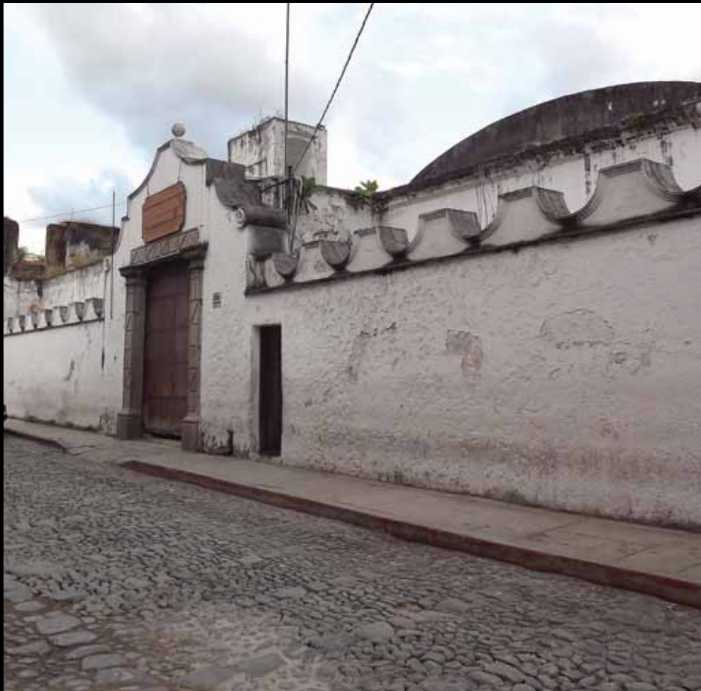
Fachada actual del edificio donde funcionó la casa de moneda
