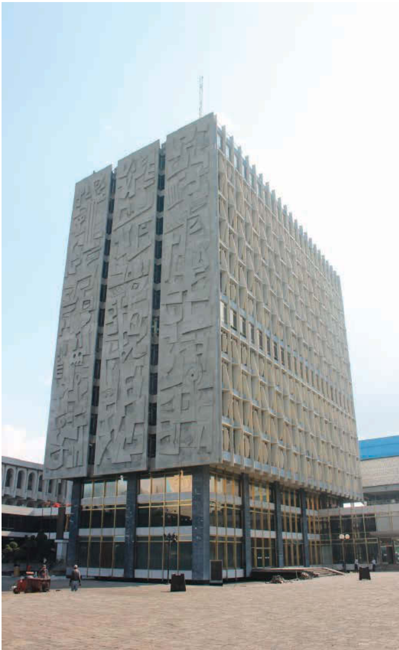
Restauración finalizada Mural poniente y fachada sur
