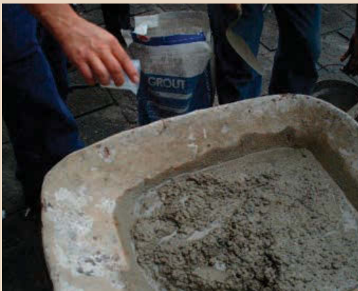
Aplicación de desencofrante
