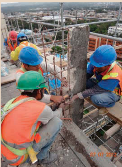
Limpieza de acero y sustitución
