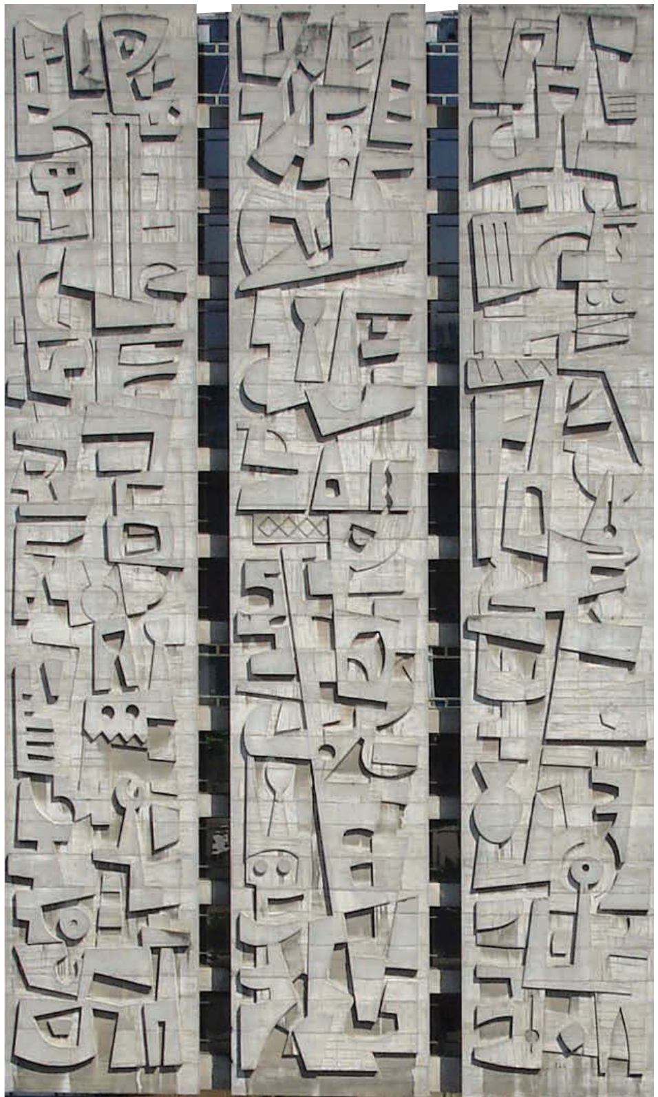
Fachada poniente del edificio, mural sin título de Roberto González Goyri
