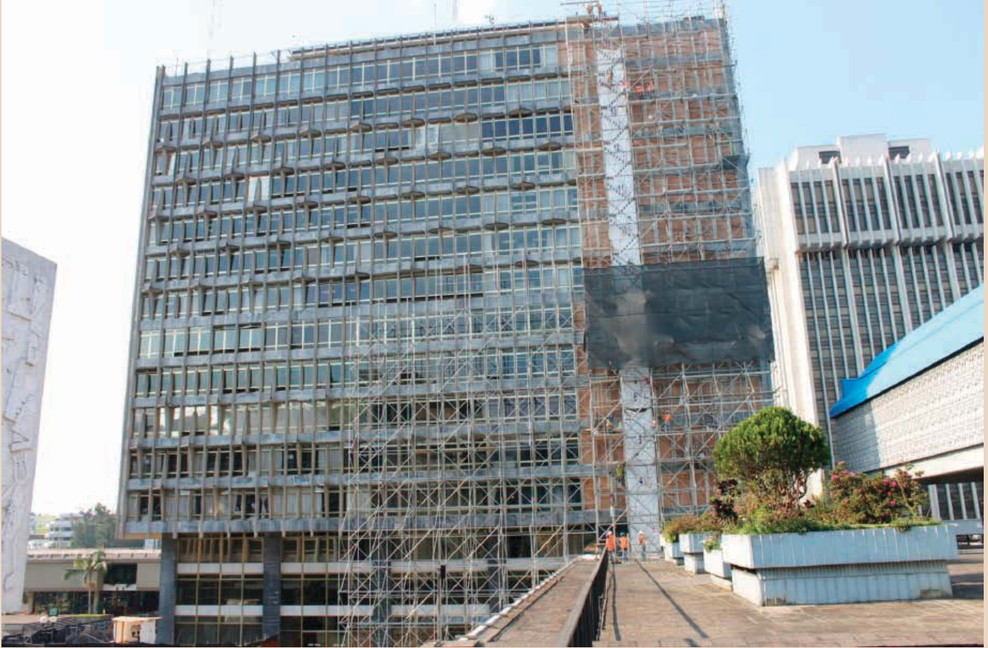
Instalación de sistema de andamiaje
