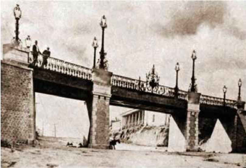
Puente de La Barranquilla
