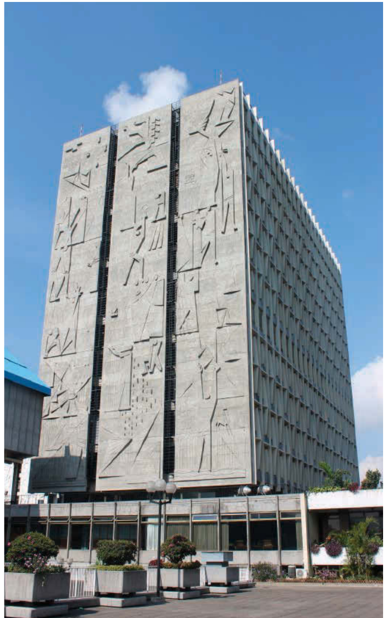
Restauración finalizada Mural oriente y fachada norte
