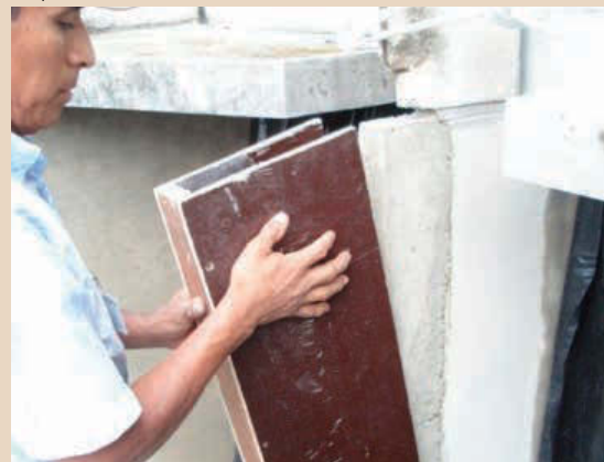
Preparación de concreto fundición
